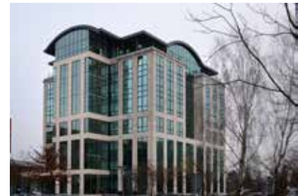
Het Quadrium-gebouw is nu voorzien van een energiezuinig luchtverdeelstelsysteem.
